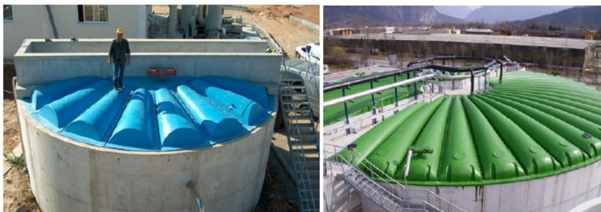
Figura 3-3 – Copertura vasche di forma circolare
